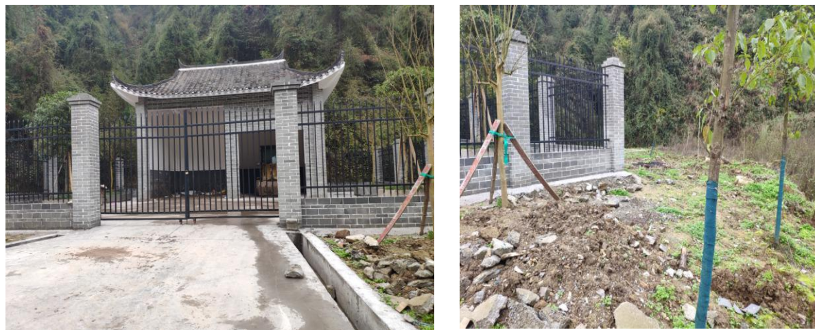
图 1.1 洗车河镇农村生活垃圾处理站现状现状图
