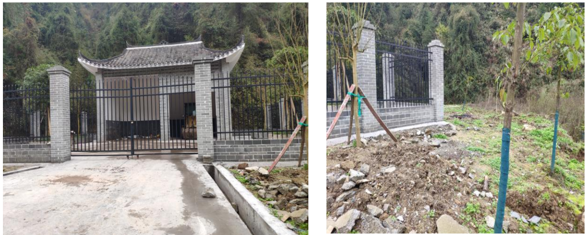
图 1.5 洗车河镇农村生活垃圾处理站现状现状图
