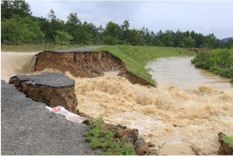
图 1.2-1 里耶防洪堤“6.20 洪水”溃堤照片
