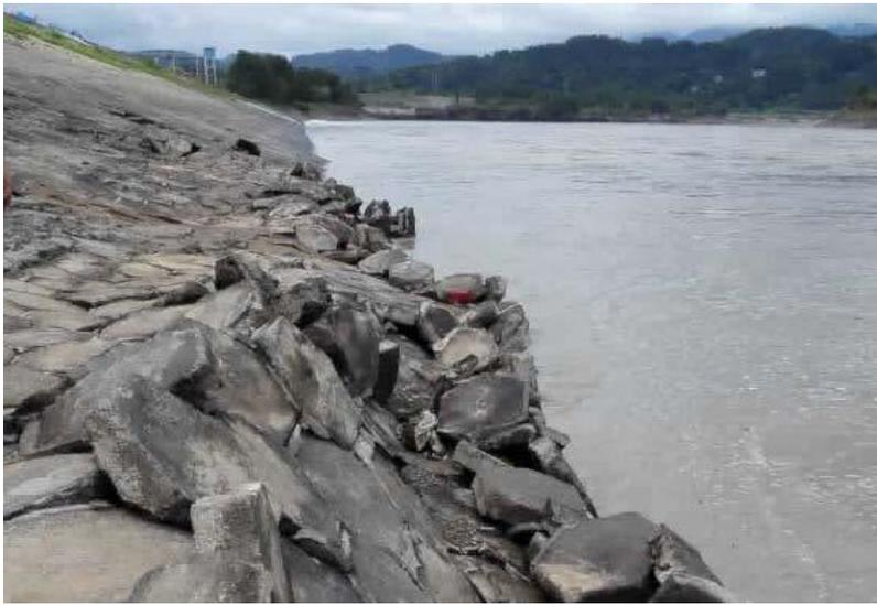
图 1.2-2 里耶防洪堤“6.20 洪水”后迎水面局部出现滑坡照片
